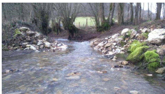
Ouvrage effacé (vue depuis l'aval à gauche) et retour d'écoulements diversifiés et remobilisation des matériaux alluvionnaires dans l'emprise de l'ancien remous (à droite) © FDPPMA52
