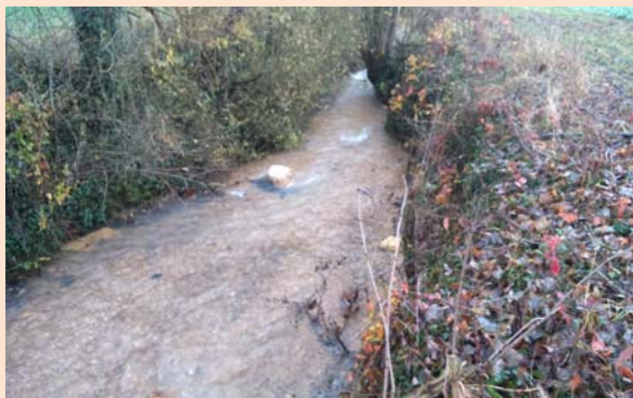
Diversification des écoulements à l'aide de blocs de diversification déposés sur le matelas alluvionnaire reconstitué en zone courante
