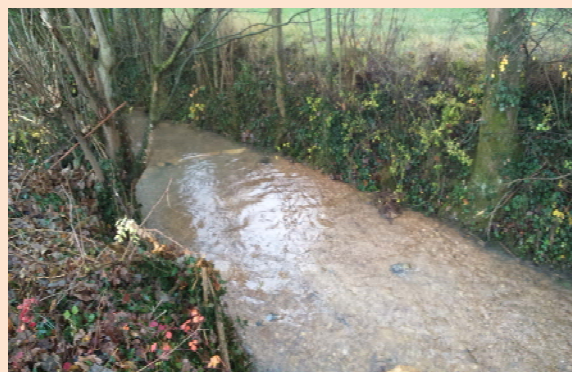
Diversification des écoulements à l'aide de blocs de diversification déposés sur le matelas alluvionnaire reconstitué en zone courante
